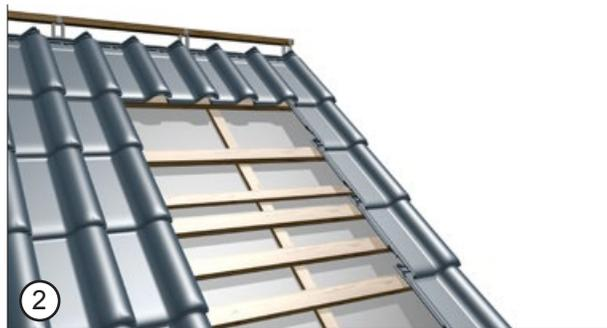
Do konstrukcji dachu należy przykręcić dwie łaty montażowe (wysokość ok. 2,5 cm – w miejscu przymocowania wspornika oraz standardową łatę w miejscu dolnego podparcia wspornika). Wysokość zamontowania łat uzależniona jest od modelu dachówki.
