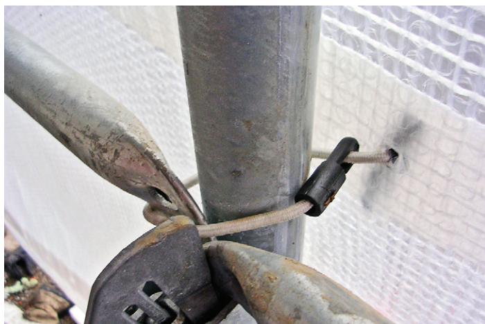
Detail kotvení plachet pružnou příchytkou
