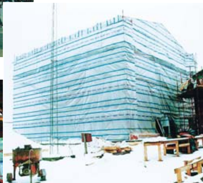
Ukázka dokonalého zateplení objektu při výstavbě plachtou NICOPROTECT FOL
