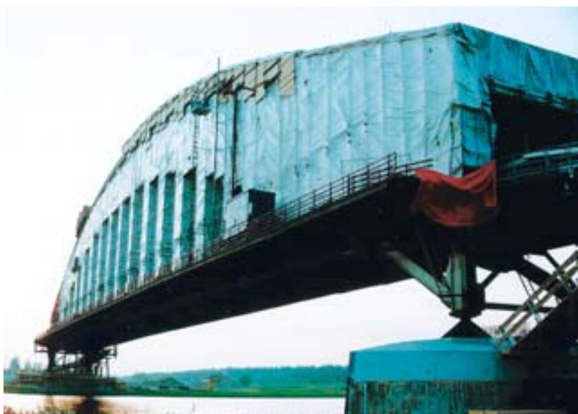
Lehká tkaná síť NICOPROTECT NET chrání okolní prostředí při renovaci mostu
